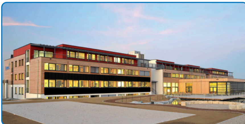
Das Nonplusultra an Energieeffizienz: Der juwi-Firmensitz in Wörrstadt.
